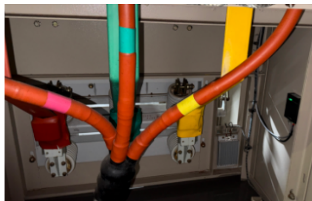
江西吉安某变电站在线监测
